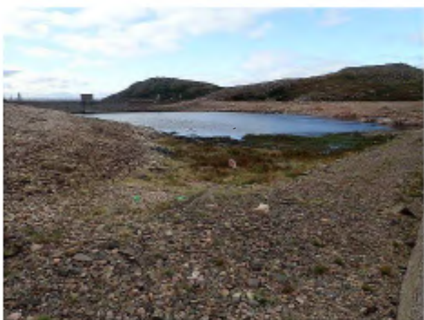
Vue du barrage de la Vigie et de la retenue aval depuis une ancienne piste d'accès à la retenue
