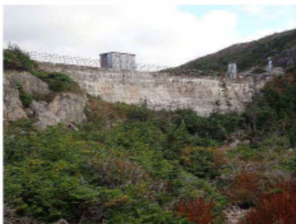
Barrage vue aval
