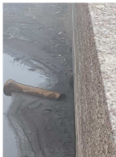
Ancienne conduite de connexion entre les plans d'eau (obturée)
