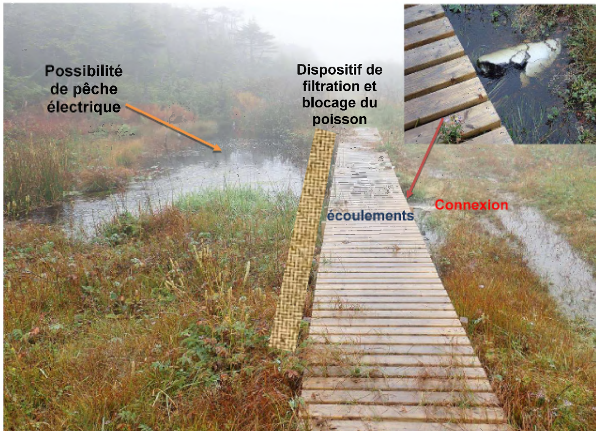
Figure 28 : Dispositif de blocage et de récupération du poisson dévalant à l'aval de la retenue
