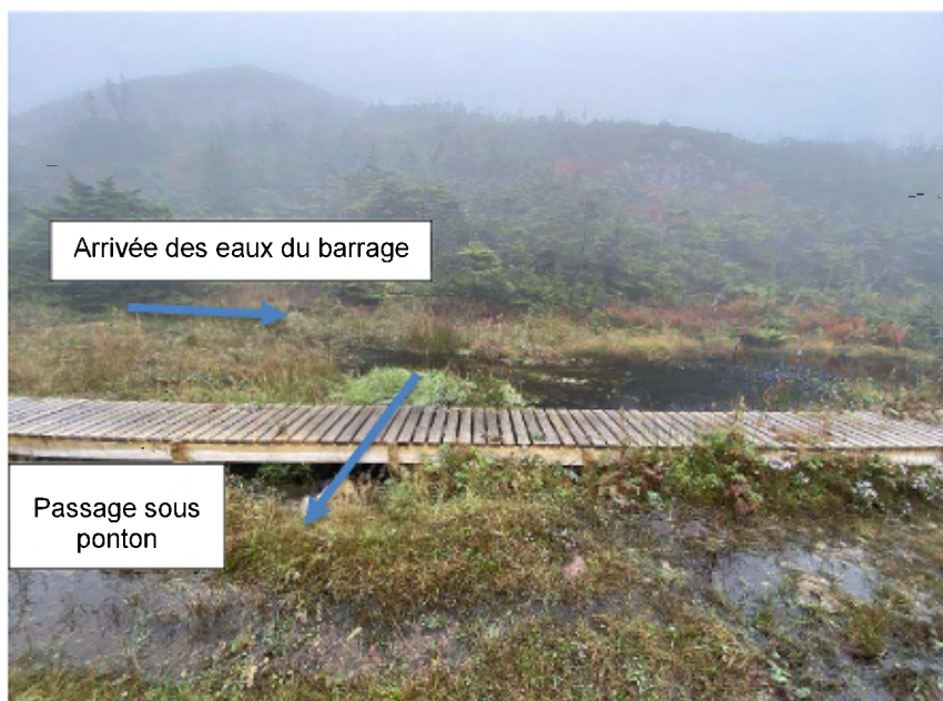
Figure 9 : Ecoulement des eaux en aval du barrage au niveau du ponton bois
