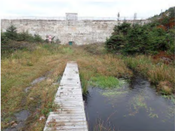
Vue de l'aval du barrage (ponton et piste à gauche)
