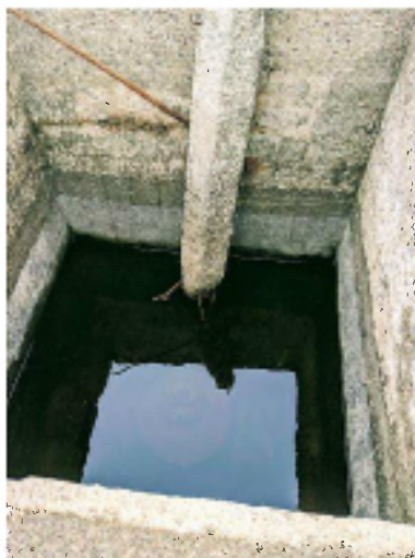
Pertuis et ancienne vanne en aval de l'ancien barrage
