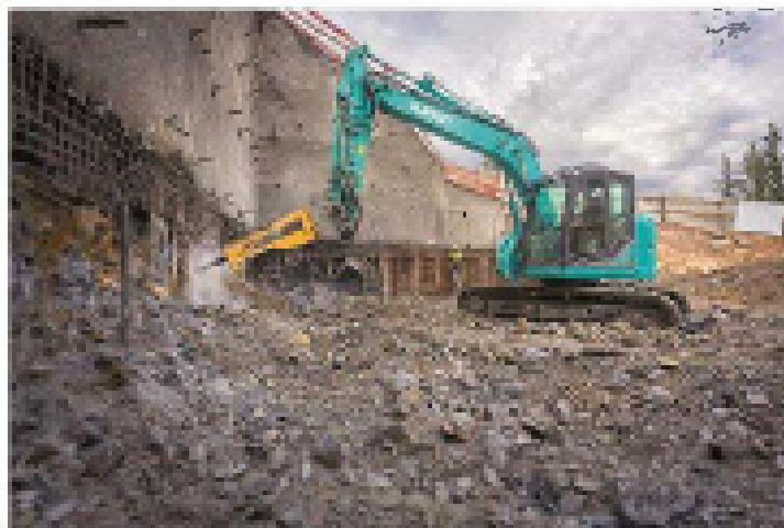
Figure 17. Exemple de démolition d'un mur de soutènement au Brise-Roche Hydraulique (source :Blanchard TP)
