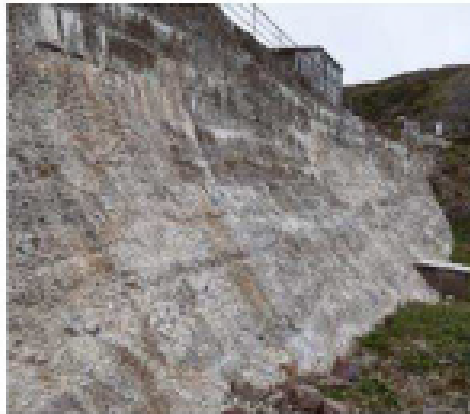
Figure 10: Vue du parement aval (Source : Reconstruction du barrage de la Vigie – Phase 1 – Rapport de diagnostic. ARTELIA, 2021)
