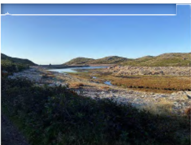
Vue de la retenue depuis la piste d'accès nord
